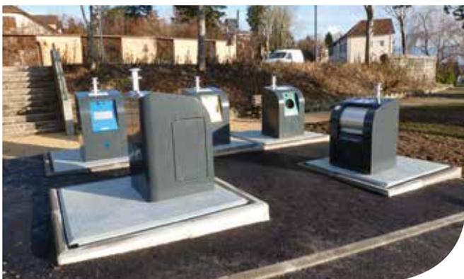
Les cuves enfouies dans le sol ont une capacité de 5000 litres. L'installation d'un conteneur correspond au volume de 8 bacs à 4 roues (660 L).
